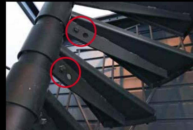
まずは、ボルト1本で仮止め状態にして、ポールリングステイを締め込み状態にする。その後、上下交互に少しずつボルトを締め込み、本締めしていく。片方を締め込みすぎると片方が緩み、踏面が内側に回転し、中に入り込みすぎるので、適正を見ながら調整します。
