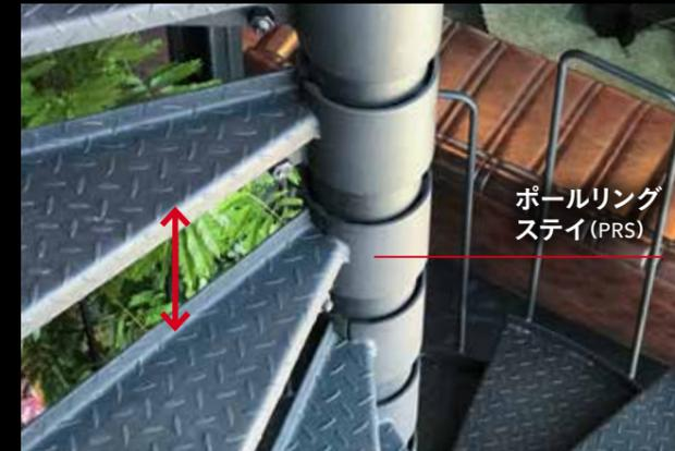
上段の踏面のエンドと下段のエンドが同じ位置にくるように合わせる。※締め込むほどに内側に入ってくるので塩梅を調整しながら作業する。
